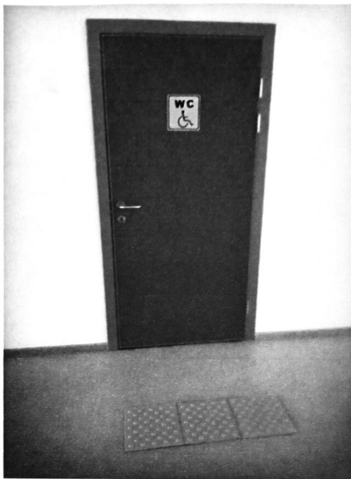
ФОТО № 6 (комната санитарной гигиены)
